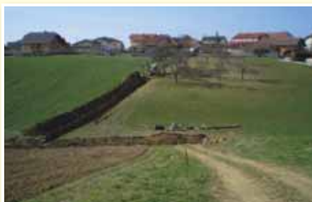
○ Gradnja dopolnilnega kanalizacijskega omrežja v občini Sv. Trojica je zahteven poseg.
